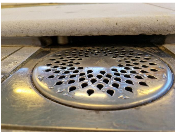
Skimmer ombyggd till avlopp
